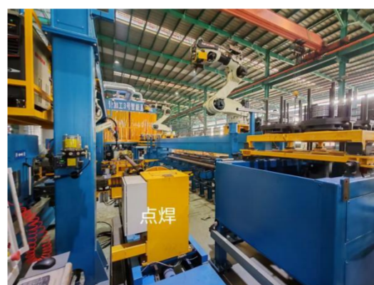
图 10 电焊焊接机器人现场
